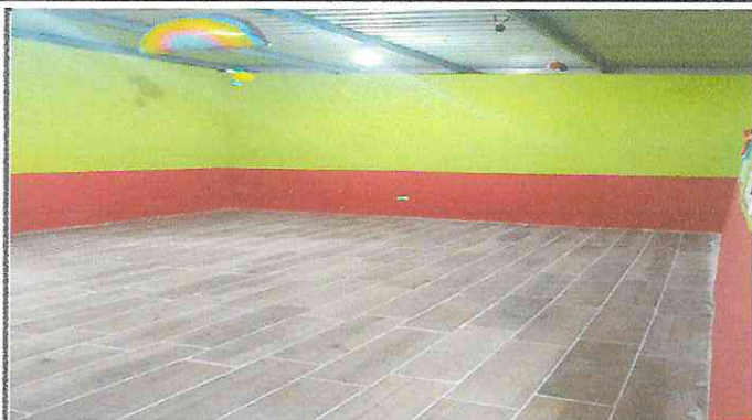
Foto1: PINTURA Y COLOCACION DE PISO EN EL AULA DE 4TO. PRIMARIA
