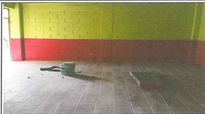
Foto 2: COLOCACION DE PISO EN EL AULA DE 2DO. SECCION B
