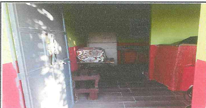
Foto 5: COLACCION DE PISO EN BODEGA Y SALA DE MAESTROS. PINTURA
