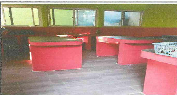
Foto 6: COLOCACION DE PISO EN LA COCINA.
